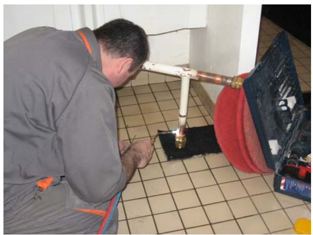
Figure 47: Brasage de la conduite pour fixer le support d'une des vannes
