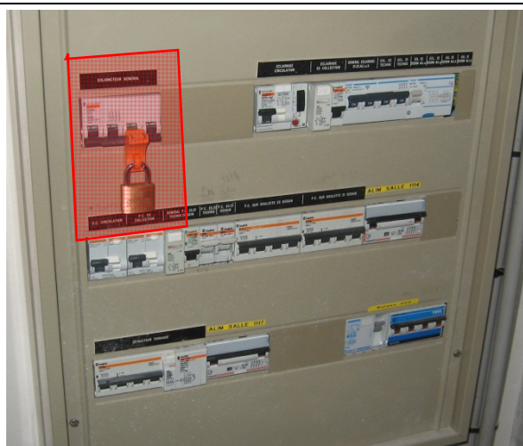
Figure 50: Installation électrique consignée avant intervention
