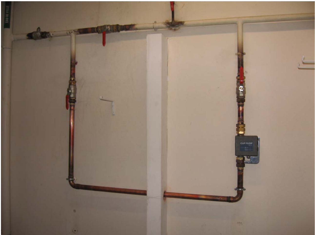
Figure 48: Le CLipFlow installé sur l'arrivée d'eau du bloc sanitaire.
