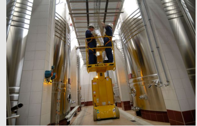
Changement d'un tube de lumière en hauteur
