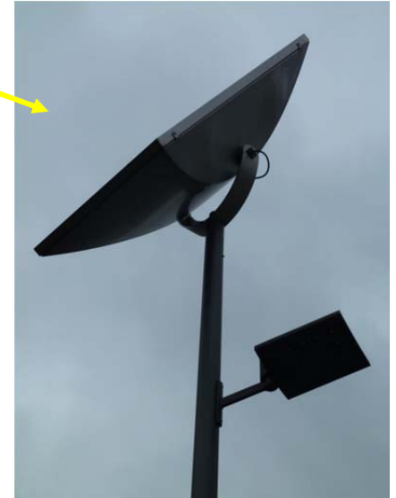
Panneau solaire pour l'éclairage à LED
