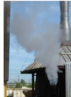
Panache de vapeur au refoulement
