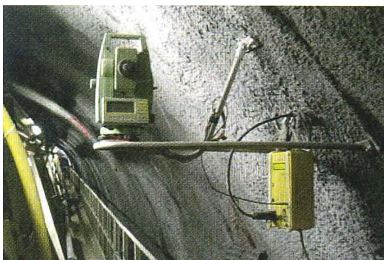
Figure 24 : Tachéomètre permettant de connaître la position exacte de la roue de coupe [13]
