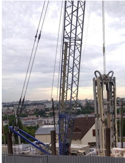
Figure 35 : Construction du puits d'évacuation au jardin panoramique de Cachan, source T. Klaeylé
