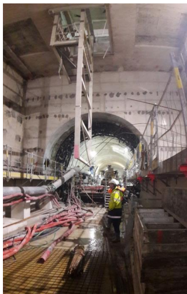
Figure 38 : Achèvement de la « boîte » de la future station Aimé Césaire, mai 2018, ligne 12 à Aubervilliers en Seine-Saint-Denis, source [24]
