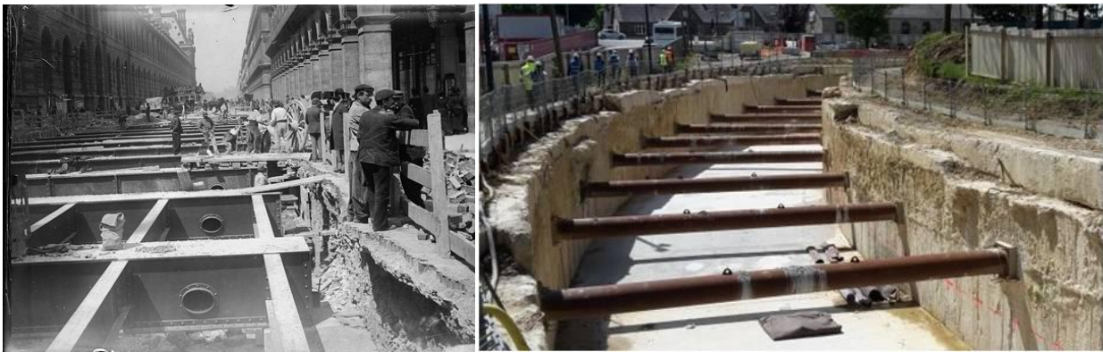
Figure 19 : Exemples de construction du métro en tranchée couverte : Paris, rue de Rivoli mai 1899, source [8], et Rennes, juin 2015, source [9]
