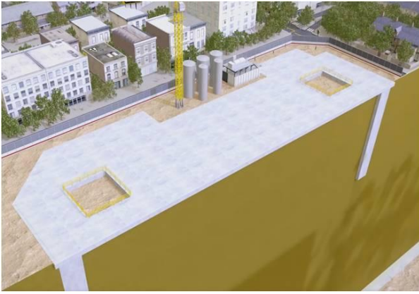
Figure 4 : Réalisation du pré-terrassement, source [2]
