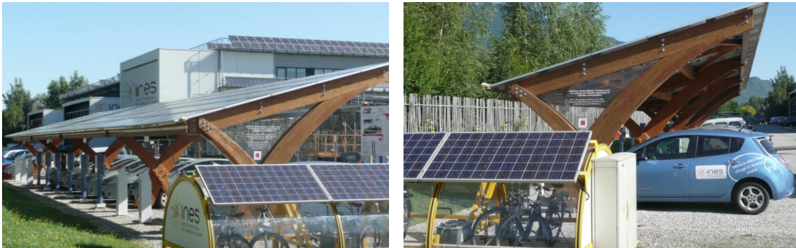
Figure 15 : Parkings avec ombrières photovoltaïques associées à des bornes de recharge à l'Institut National de l'Energie Solaire, Le Bourget du Lac, photos B. Multon
