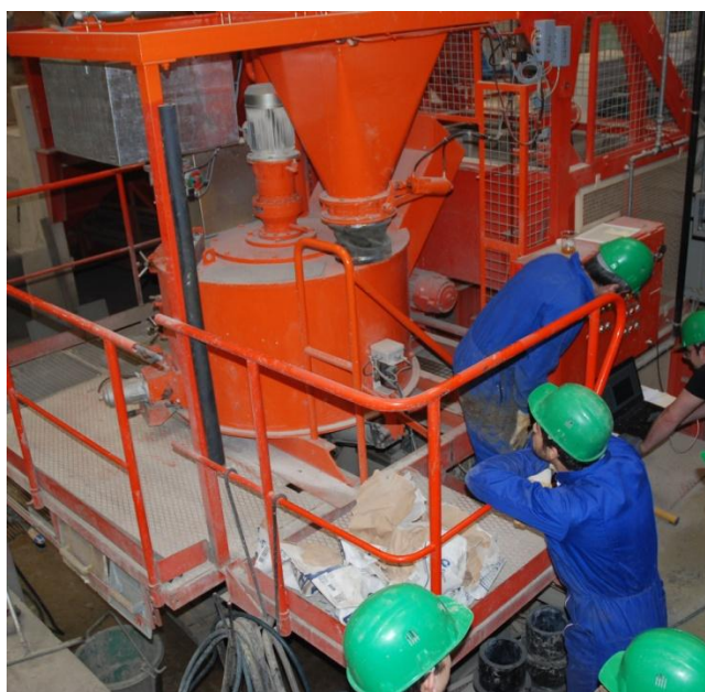
Figure 16 : Centrale à béton, malaxage des composants
