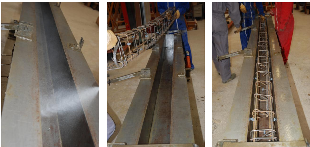
Figure 27 : Graissage du moule et installation de la cage
