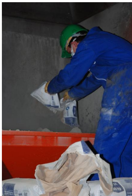
Figure 14 : Ouverture du sac de ciment (EPI masque et gants)
