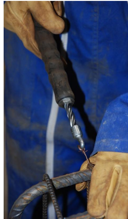
Figure 11 : Utilisation du lieur automatique
