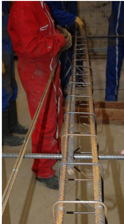
Figure 10 : Positionnement des cadres
