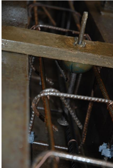
Figure 29 : Finalisation du moule avant remplissage de béton
