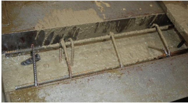
Figure 31 : Après mise en vibration du moule
