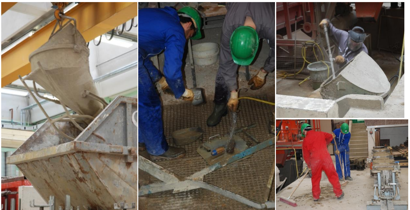
Figure 41 : Évacuation des déchets dans une benne spéciale, nettoyage de l'outillage à l'eau sous pression ou non, et balayage
