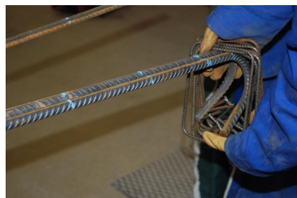
Figure 8 : Installations des cadres
