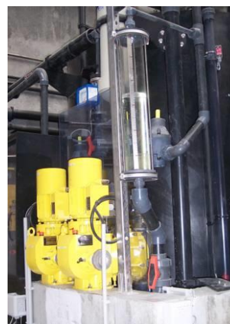
Les pompes doseuses de Javel A et B de la tour de lavage Javel
