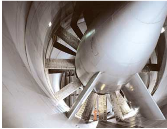
Illustration 3: Vue de l'intérieur de la soufflerie -- Ventilateur
