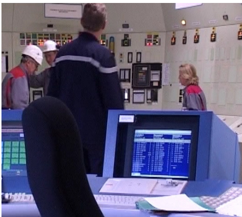
L'opérateur travaille en liaison avec la salle de contrôle
